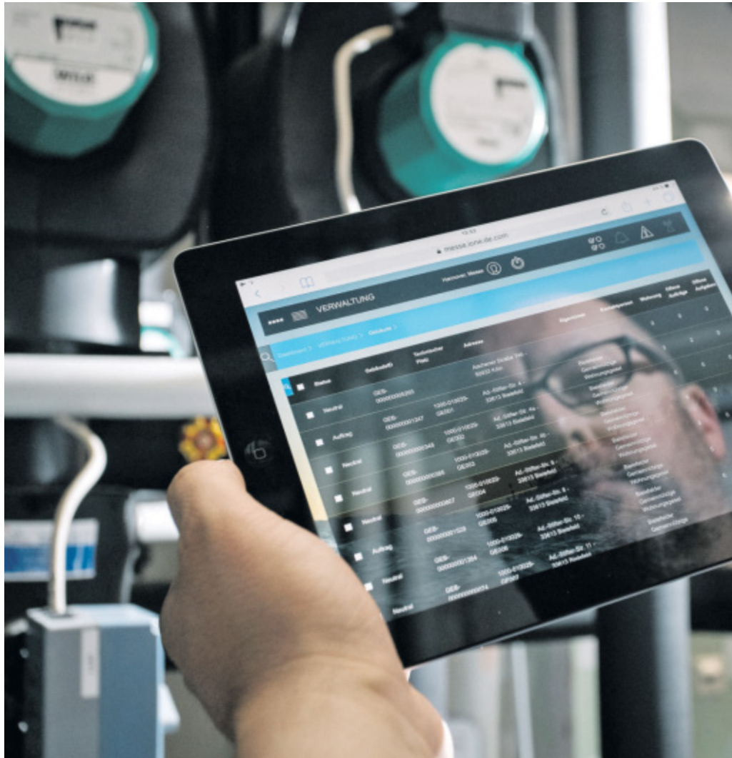
Handwerk 4.0: Über ein Tablet protokolliert der Techniker die Arbeiten.
